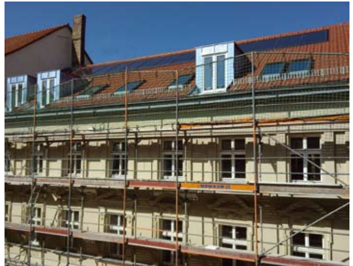
Denkmalgeschütztes Gründerzeithaus Schönerlinder Str. 6 in Berlin-Köpenick während der Sanierung
